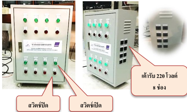
รูปที่ 11 ระบบควบคุมไฟฟ้าอัจฉริยะแบบเคลื่อนที่แบบสำเร็จ
