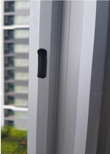
ภาพที่ 6 ตัวรับล๊อคที่เจาะรูที่เฟรม Section ก่อนปรับปรุงของบริษัทฯ
