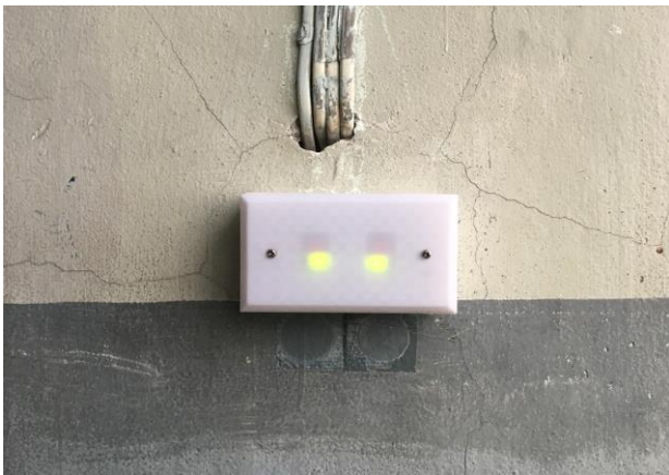
รูปที่ 5 การติดตั้งชุดควบคุมการเปิด-ปิดหลอดไฟผ่านเว็บ
