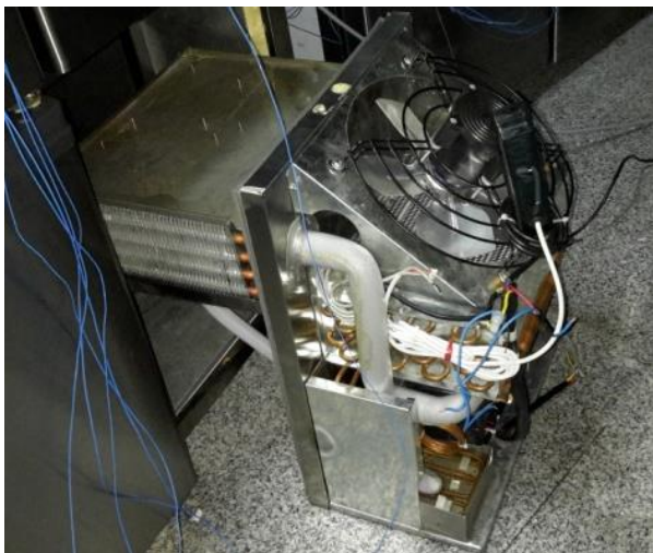
รูปที่ 3 การถอดห้องเครื่องเพื่อติดตั้งสายวัดอุณหภูมิ
