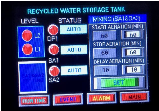
ภาพที่ 1.6 WWTP. Smart Monitoring ขณะกำลังทำงาน ในส่วนของน้ำ รีไซเคิล
