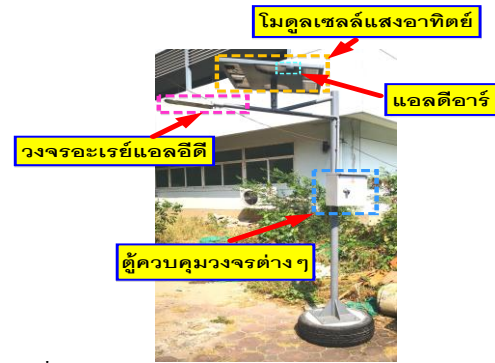
รูปที่ 3 คอนเวอร์เตอร์แบบซิงค์ตัวสำหรับของโคมไฟแอลอีดีกำลังสูงที่เสร็จสมบูรณ์
