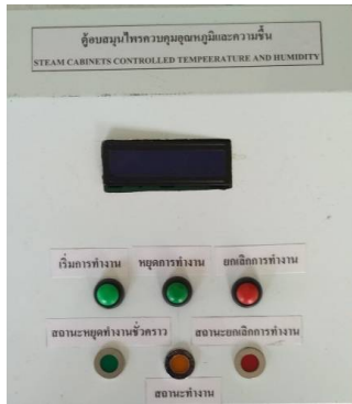
รูปที่ 5 การติดตั้งอุปกรณ์ต่างๆ
