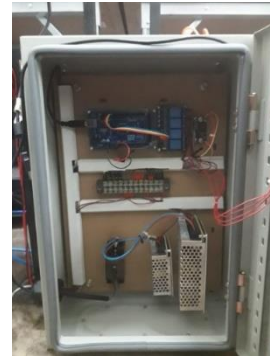
รูปที่ 2 อุปกรณ์ภายในตู้ควบคุม
