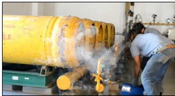
รูปที่ 3 การกระจายของแก๊สคลอรีนขณะซ่อมบำรุง
