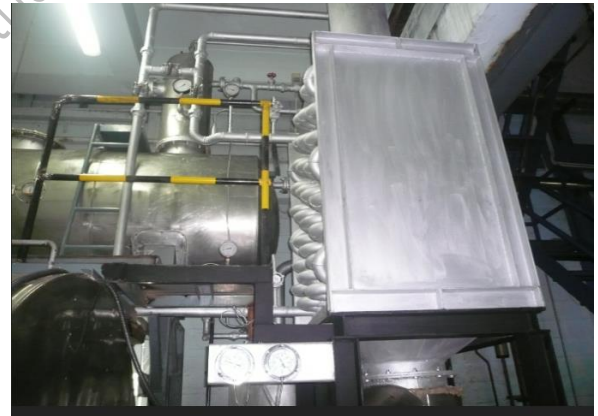
ภาพที่ 3 แสดงการติดตั้งอีโคโนไมเซอร์
