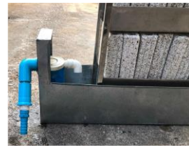
รูปที่ 10 ติดตั้งก๊อมน้ำลูกกลอย และข้อต่อสำหรับติดตั้งกับก๊อมน้ำลูกกลอย ติดกับถาดเก็บน้ำ
