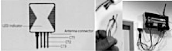
รูปที่ 3 ติดตั้งอุปกรณ์ตรวจวัดค่าทางพลังงาน
